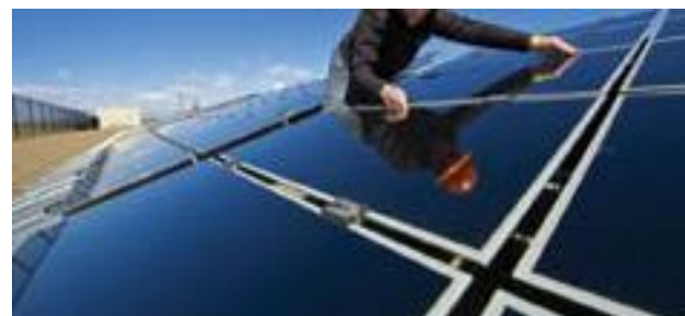
4.Thi công lắp đặt
